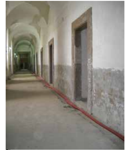
Photo avant travaux
