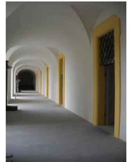
Photo après travaux
