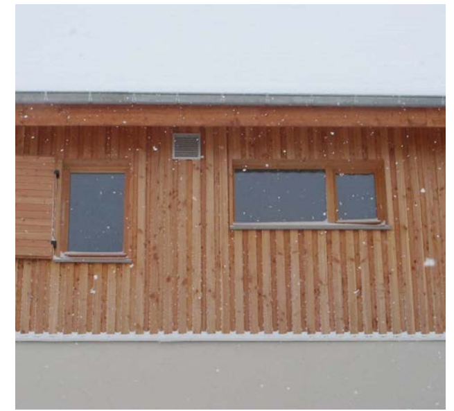
Détail du bardage
