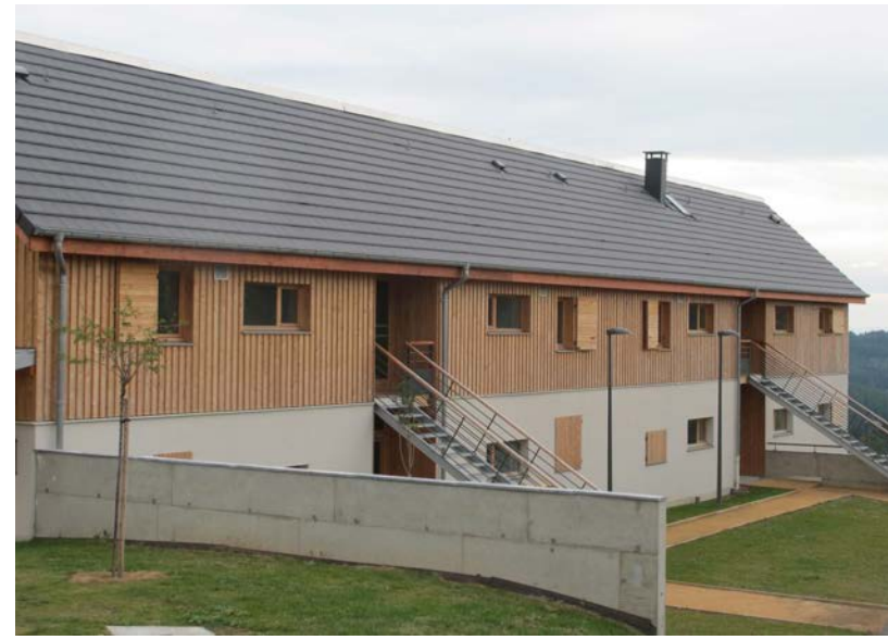
Vue de la Façade Nord
