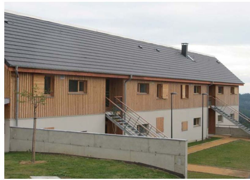
Vue de la Façade Nord
