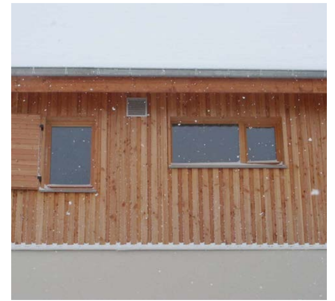
Détail du bardage
