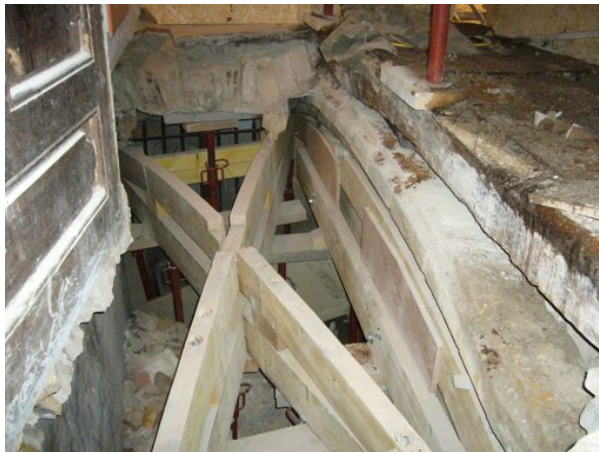
Restauration de la voûte
