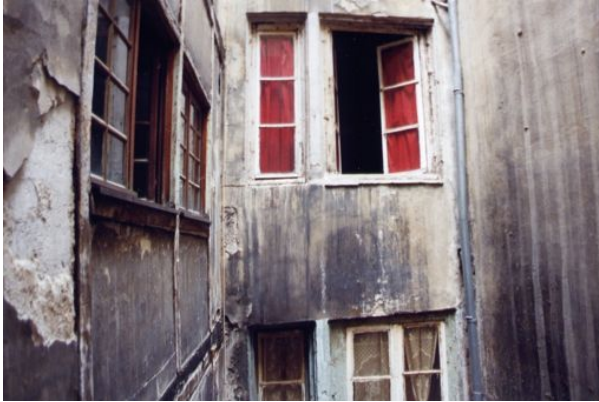
Etat de la façade avant les travaux
